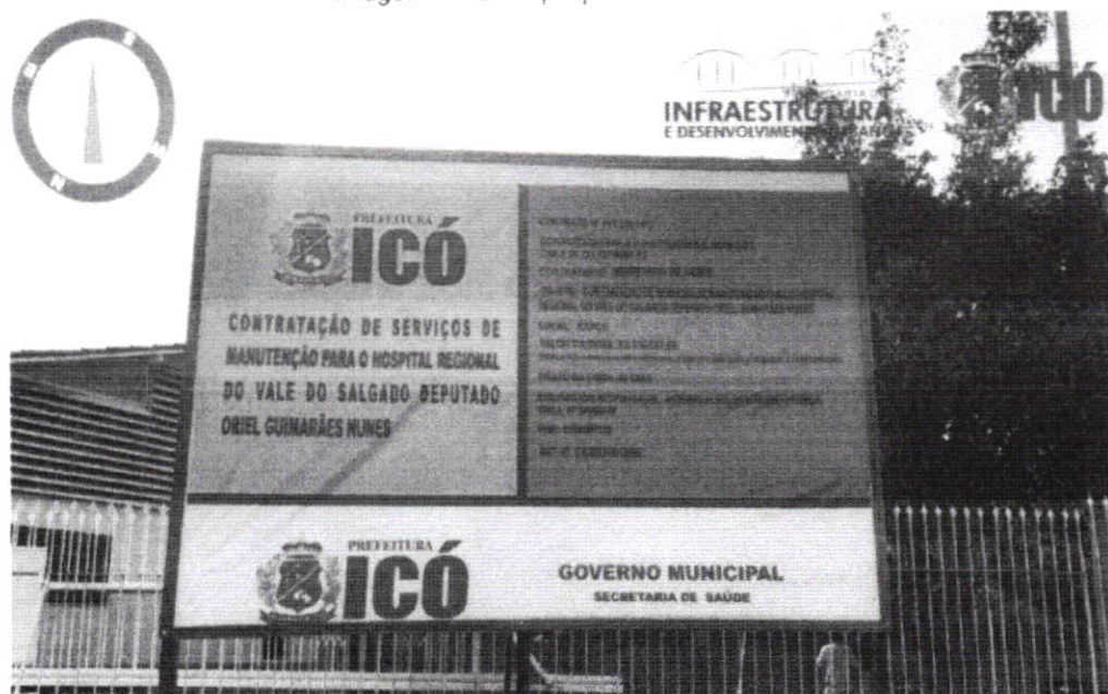
Imagem 1 – Exemplo placa de obra
