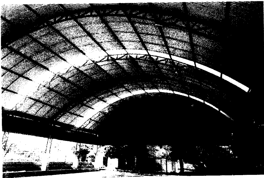
FOTOGRAFIA 2- ESTRUTURA DA COBERTURA.
