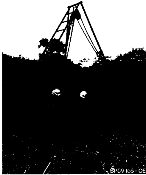
SP09 Icó - CE FIGURA 2:EXECUÇÃO DE SONDAGEM EM ICÓ-CE
