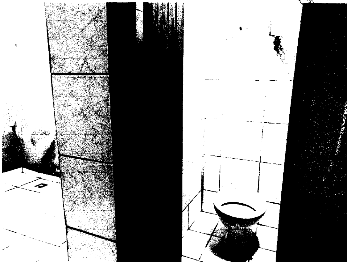
Imagem 3: Demolição da louça sanitária.
