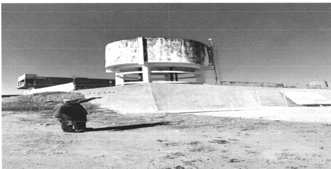
VISTA GERAL DA OBRA (FACHADA PRINCIPAL)
