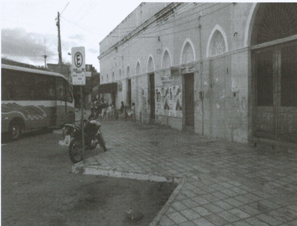
Pavimentação em Paralelepípedo Estacionamento
