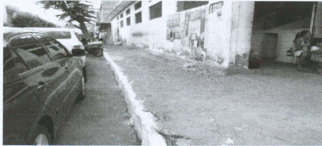
DEMOLIÇÃO DE PISO CIMENTADO SOBRE LASTRO CONCRETO
