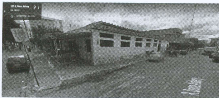
DEMOLIÇÃO DE ALVENARIA DE TIJOLO C/REAPROVEITAMENTO
