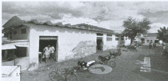
DEMOLIÇÃO DE REVESTIMENTO C/ARGAMASSA
