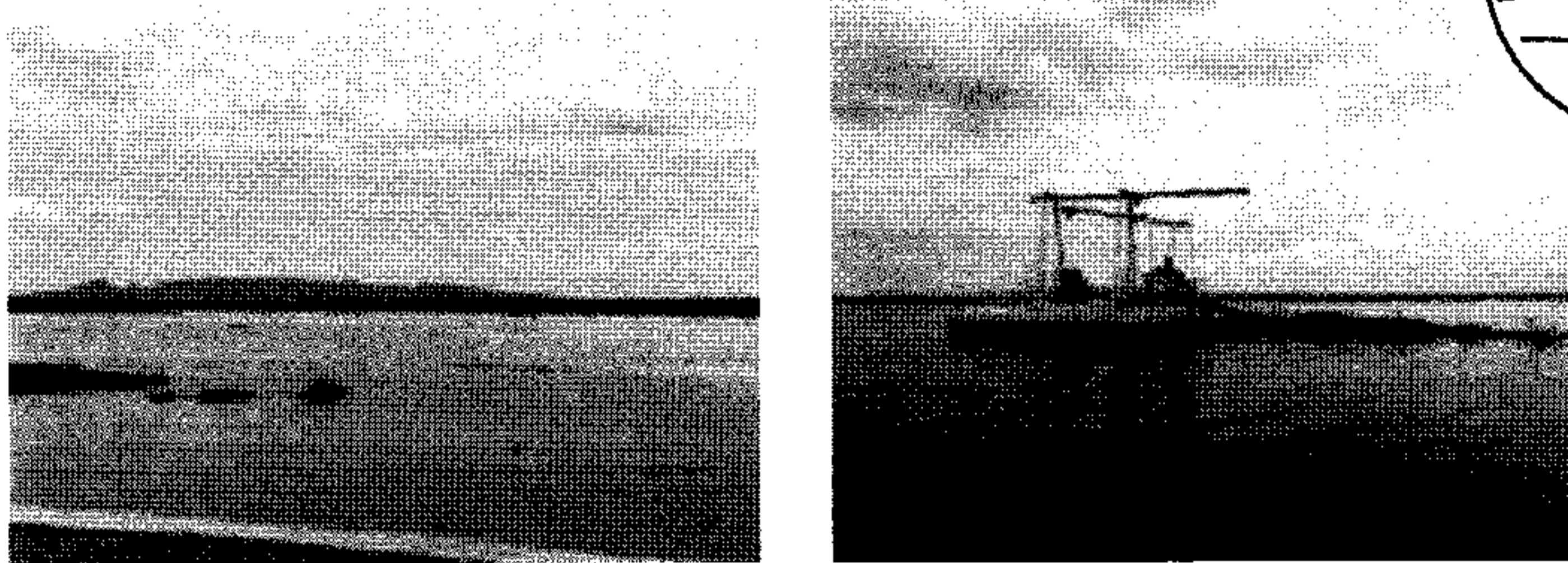
Figura 4 - Captação de Água Bruta - Açude Lima Campos. Fonte: Fundação CETREDE.
