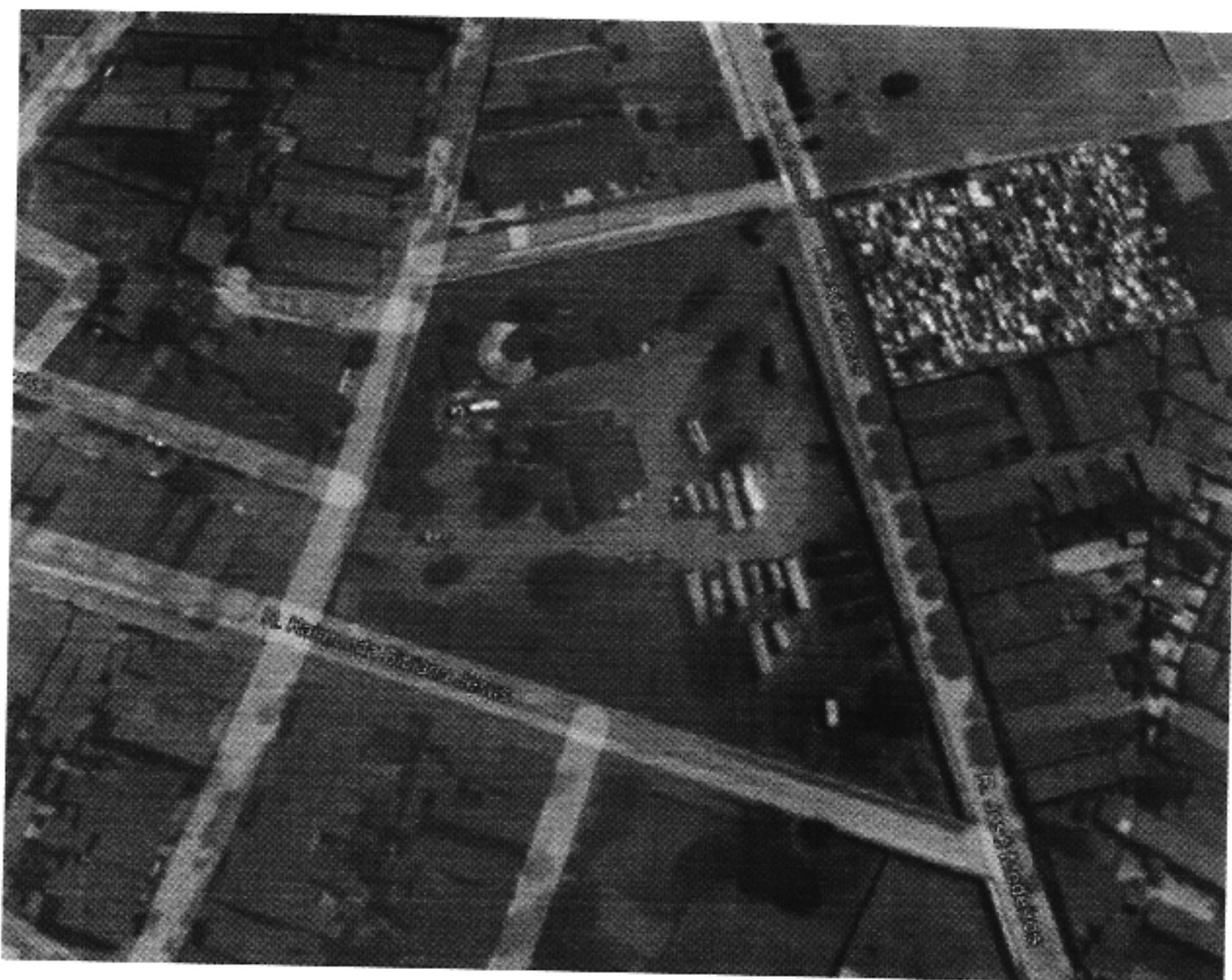
Figura 8 - Vista aérea da ETA da Sede Municipal de Icó (CE). Fonte: Google Earth, 2021.
