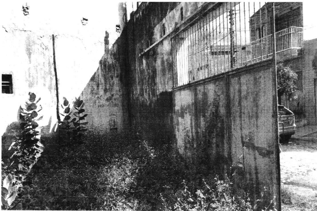
FOTO 3 – DETALHE DO PORTÃO DE ENTRADA – PARTE INTERNA
