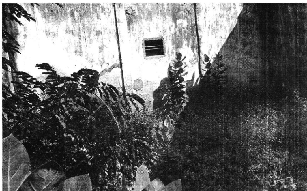
FOTO 5 – ÁREA LIVRE LADO - DIREITO DA FACHADA PRINCIPAL ONDE SERA CONSTRUÍDO SANITÁRIOS E REFEITÓRIO
