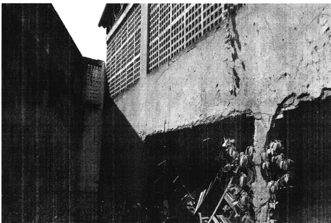
FOTO 7 – DETALHE DA FACHADA PRINCIPAL QUE SERA RECUPERADA – LADO ESQUERDO
